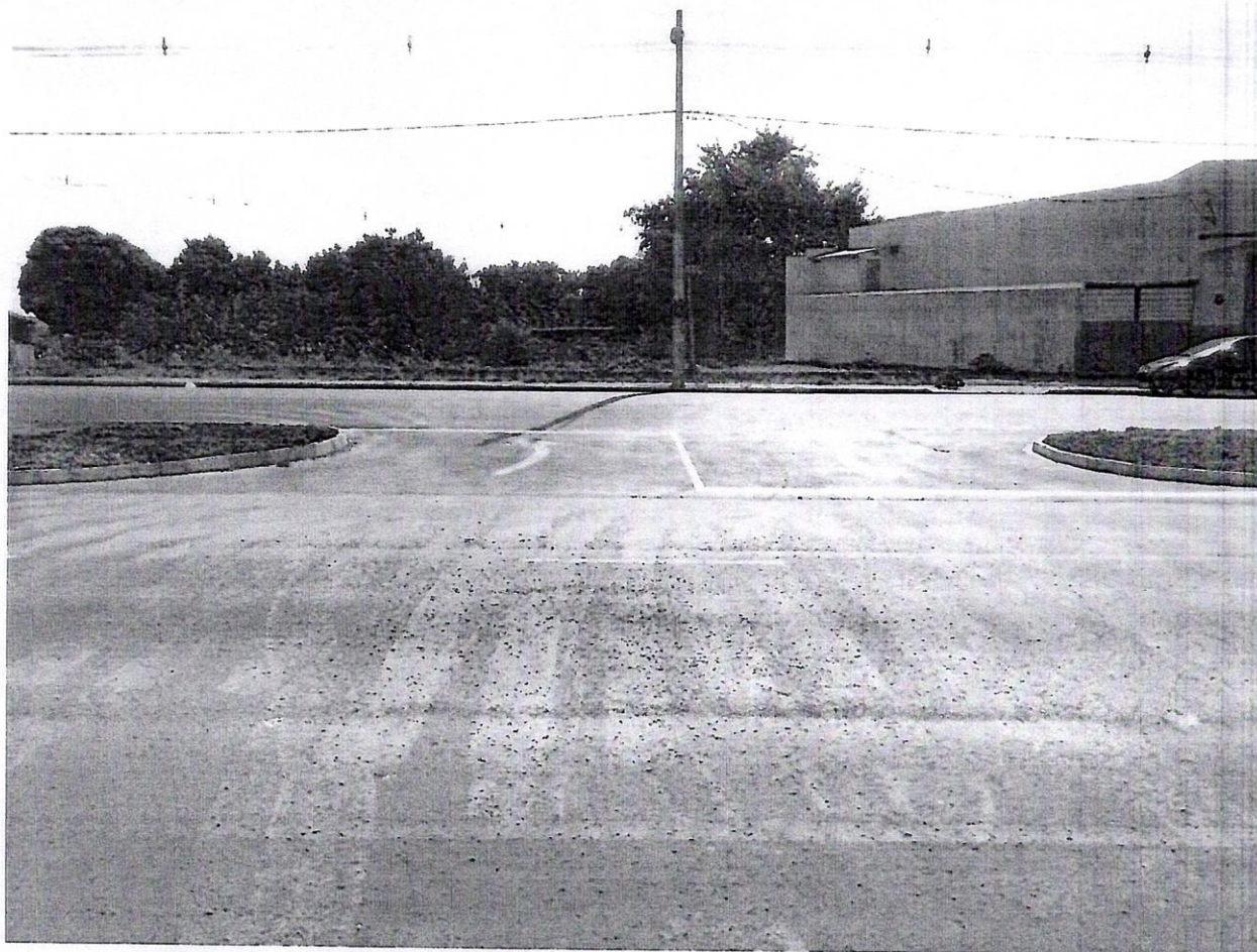
Figura 01 – Abertura de Canteiro Avenida Pedro Taques x Rua Acopiara
